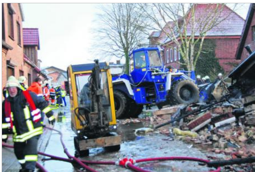
Ein Radlader des Technischen Hilfswerks räumte die Trümmer der eingestürzten Brandruine von der Straße Foto: Arne Kolarczyk
